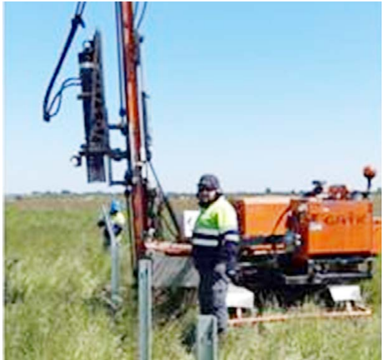
Les panneaux solaires de la deuxième phase sont en cours d'installation. Elle sera mise en service début 2021.
