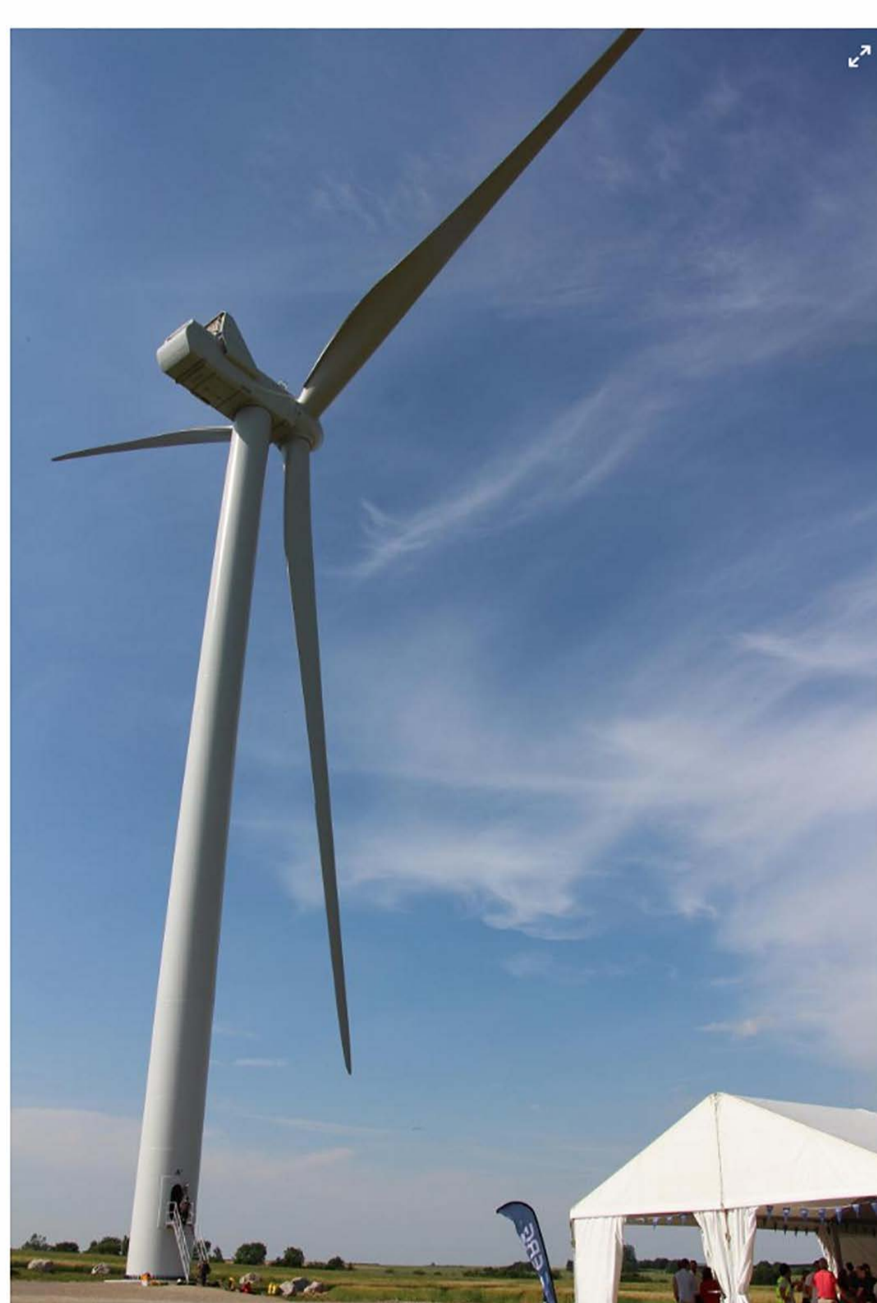
L'une des deux éoliennes du parc de la Vallée de l'Aa Est II.
